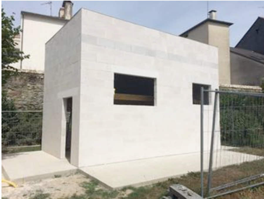
construction de l'oeuvre de Jean-Pascal Flavien dans le cadre de Incorporated!
